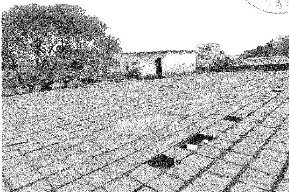
照片 6 屋面现状图（一）
