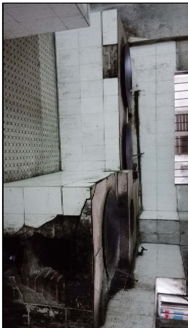
拆除厨房灶台瓷砖饰面示意图
