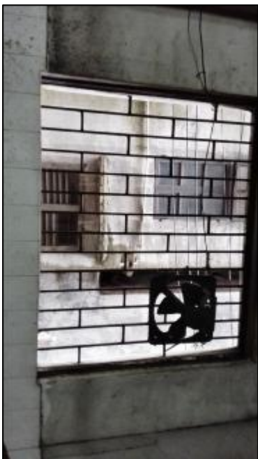
⑧ 拆除厨房铁艺窗户示意图
