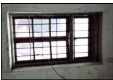
② 拆除厨房木条铁艺窗户示意图
