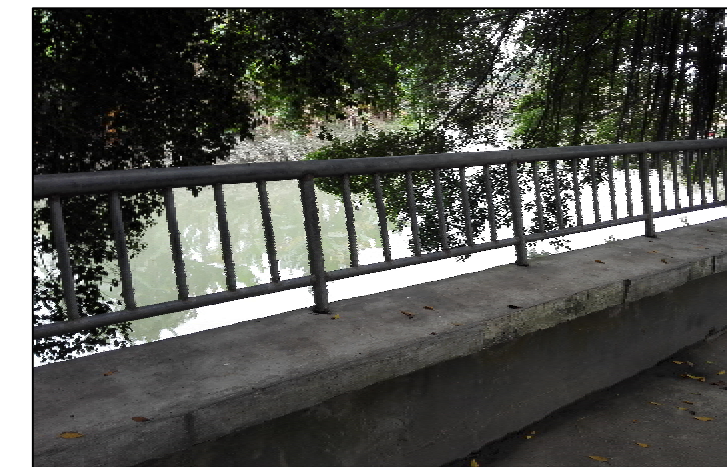
栏杆及挡墙翻新现状图
