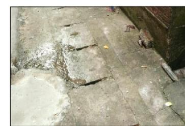
④ 拆除巷道排水盖板示意图
